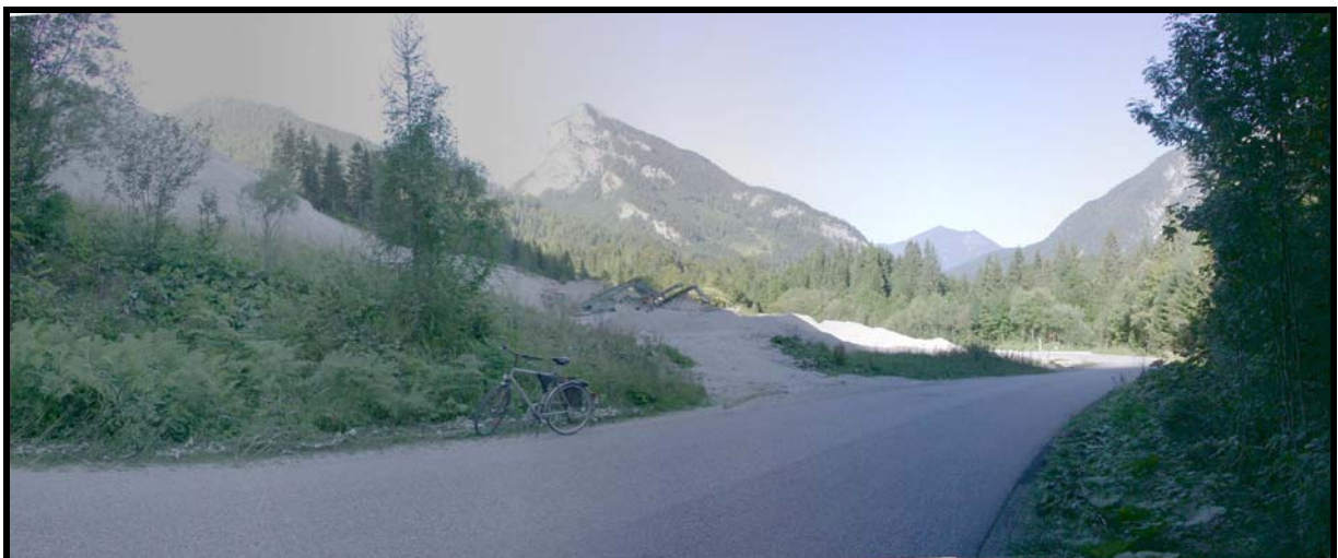
Blick auf die Schottergrube Thorbach aus südlicher Richtung
